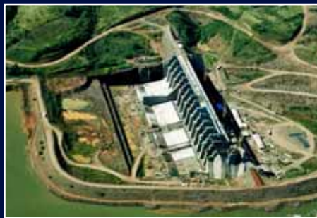
UHE Foz do Chapecó - Foz de Chapecó Energia S.A. Foz do Chapecó HPP - Foz de Chapecó Energia S.A.
