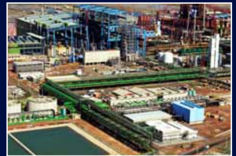
Sistema de Tratamento de Água e Tubulações de Interconexões a Siderúrgica CSA - Thyssenkrupp CSA Siderúrgica do Atlântico Water Treatment and Interconnecting Piping for Siderúrgica CSA - Thyssenkrupp CSA Siderúrgica do Atlântico
