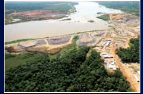
UHE Santo Antonio - Santo Antonio Energia (RO) Santo Antonio HPP - Santo Antonio Energia - (RO)
