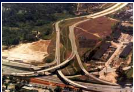
Recuperação de rodovias - DER - (SP)
