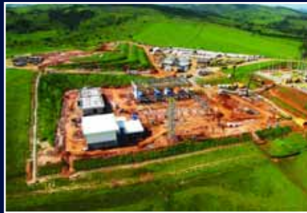
Estação de compressão de gás natural no Vale do Paraíba - Transportadora Associada de Gás - TAG - (SP) Natural gas compressor station in the Paraíba Valley - Transportadora Associada de Gás - TAG - (SP)
