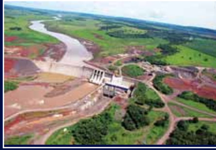
UHE Barra dos Coqueiros - (GO) Barra dos Coqueiros HPP - (GO)
